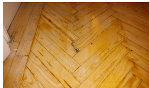
Pasmado o veladura + rallas de lija: se genera normalmente por vapor de agua que se mezcla con el barniz.
