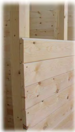
Ranura de las tablas para disminuir los movimientos por cambios de humedad.
