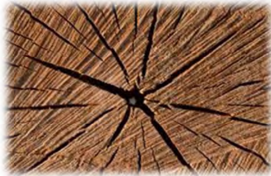
Grietas / pata de gallo
